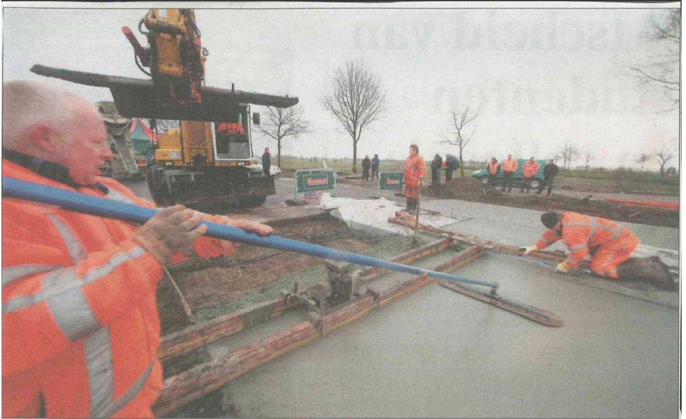
Staphorst heeft de primeur in Nederland. Een rotonde bij de Gorterlaan wordt gemaakt van staalvezelbeton. Sterk, duurzaam, onderhoudsarm. Waarschijnlijk is de rotonde nog als nieuw als Staphorst over een paar jaar bij de nieuwe gemeente Horst- en Waterland hoort. Boom regionale uitgevers / Wilbert Bijzitter
